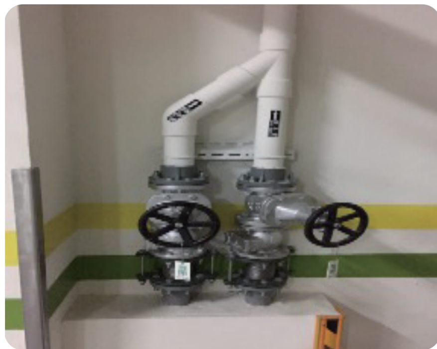
排水の改善-雨水専用パイプライン
