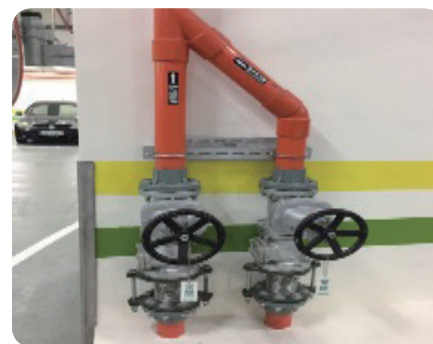
排水の改善-廃水専用パイプライン
